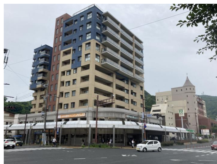
令和7年現在 マンション
